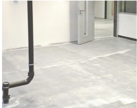
Abb. 2: Ansicht Laborraum während Sanierungsarbeiten
